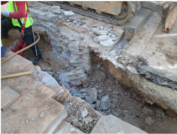
79. Desmuntatge fonamentació UE 7 a c. Fernando Pessoa
