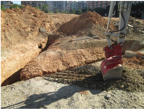
7. Inici excavació Rasa 2
