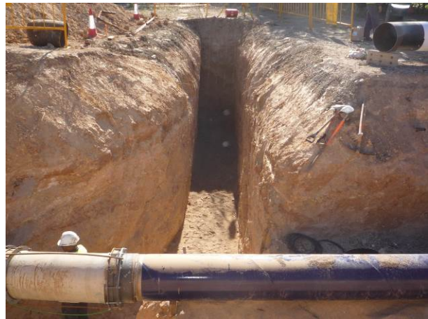
58. Ramal S del primer tram de la Rasa 8
