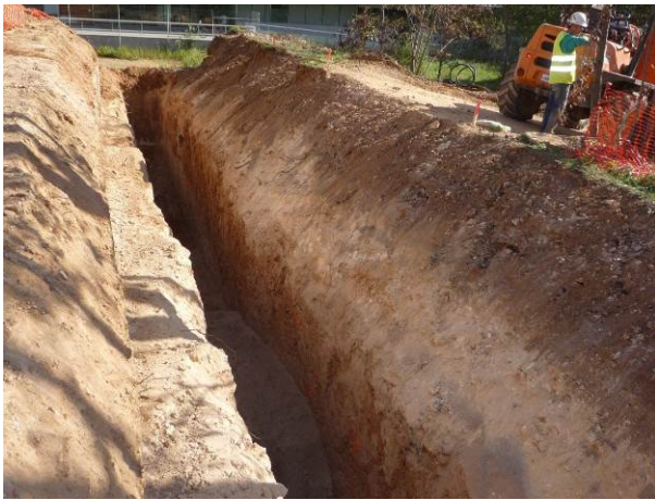
55. Extrem O del primer tram de la Rasa 8
