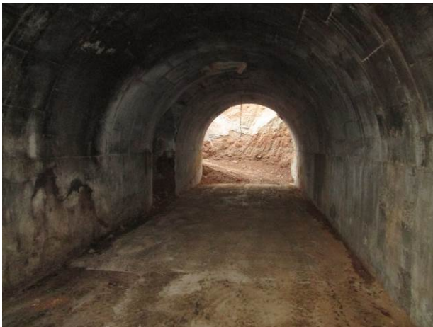
27. Interior del túnel UE 6
