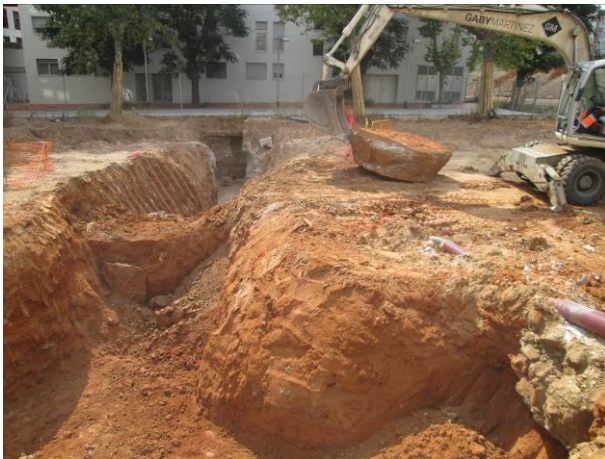
39. Retirada de fonamentacions a la Rasa 7.
