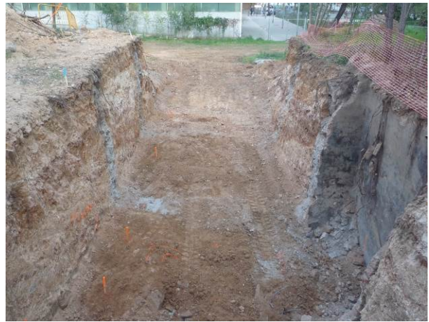
62. Excavació del ramal O
