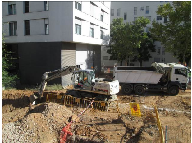
32. Excavació extrem E de la Rasa 6
