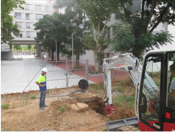
1. Inici excavació Rasa 1
