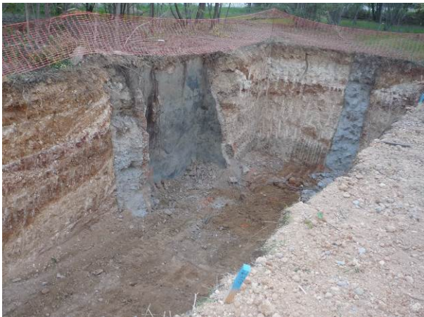
63. Restes de fonamentació i pou sec al ramal de Rasa 8
