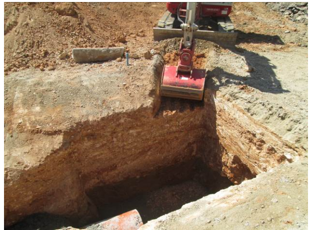
16. Inici excavació Rasa 4
