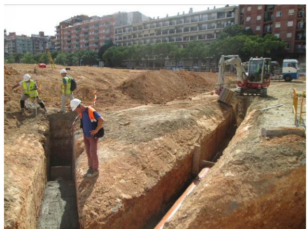
12. Excavació de Rasa 3
