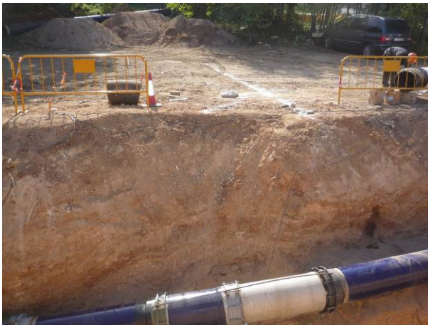
57. Ramal S del primer tram de la Rasa 8
