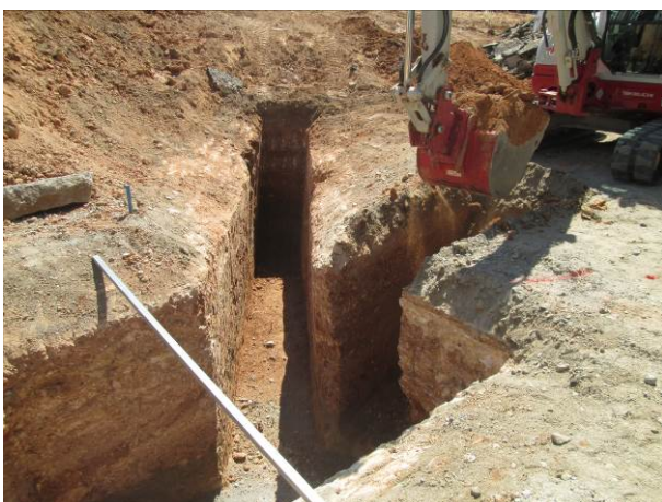
11. Inici excavació Rasa 3
