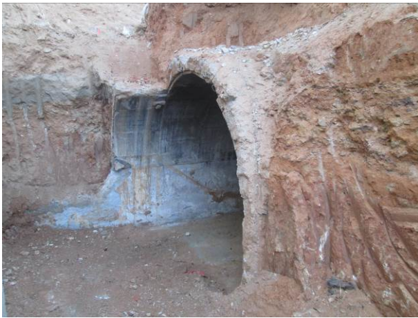
25. Extrem est del túnel UE 6
