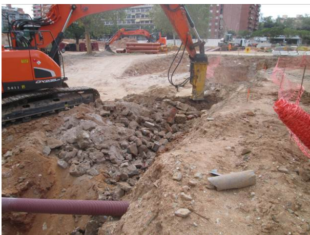
29. Demolició de la fonamentació UE 7 a la Rasa 6
