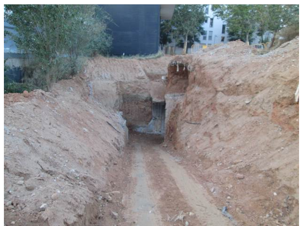
24. Extrem est del túnel UE 6
