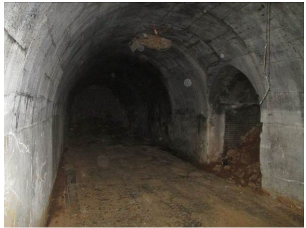
26. Interior de l'extrem est del túnel UE 6
