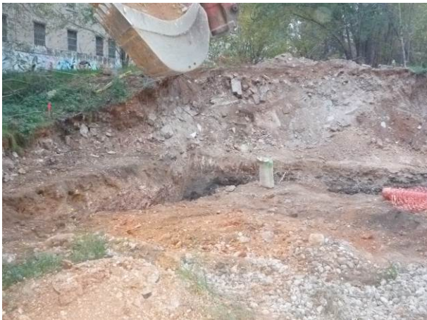
69. Excavació segon tram Rasa 8
